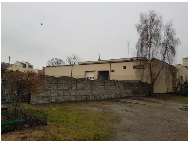
Fot. 1 Płot na terenie JRG
