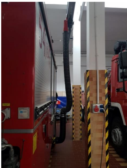
Fot. 1 Wyciąg spalin na garażu C
