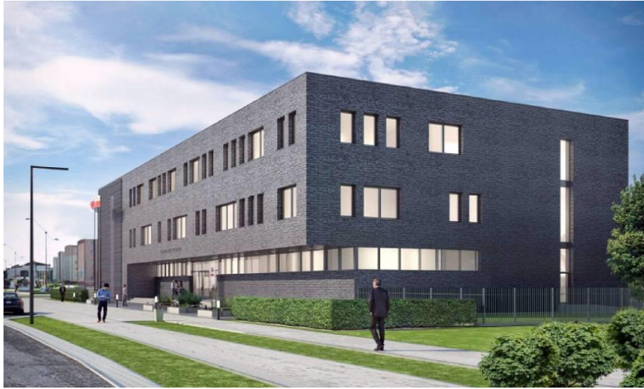
Rys. Budynek Sądu Rejonowego w Tczewie (źródło Internet).
