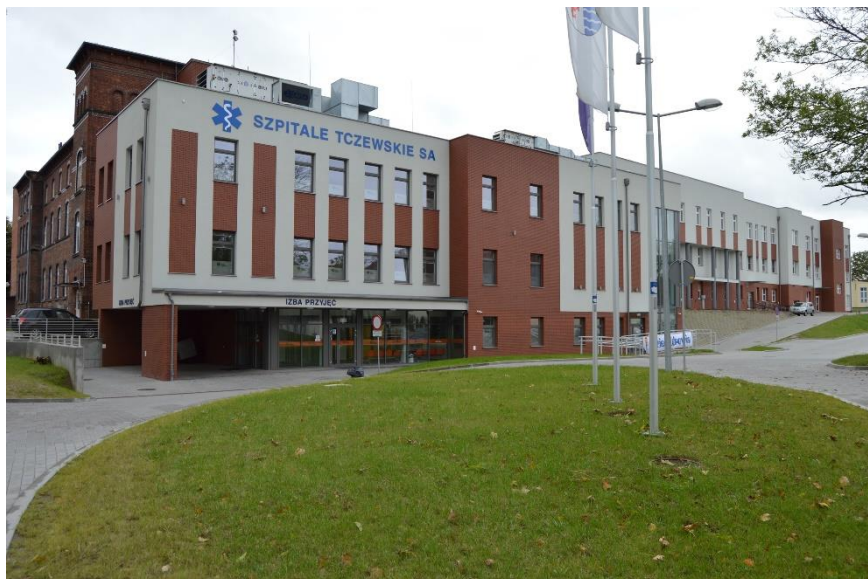
Rys.1 Budynek rozbudowanego szpitala w Tczewie.
