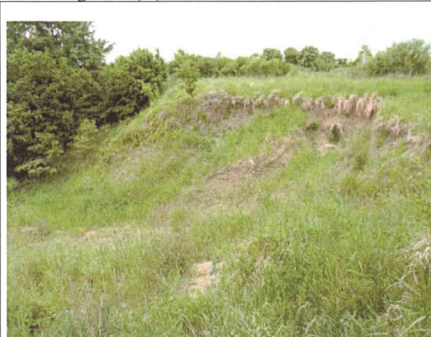
Fot.1. Skarpa główna osuwiska.
